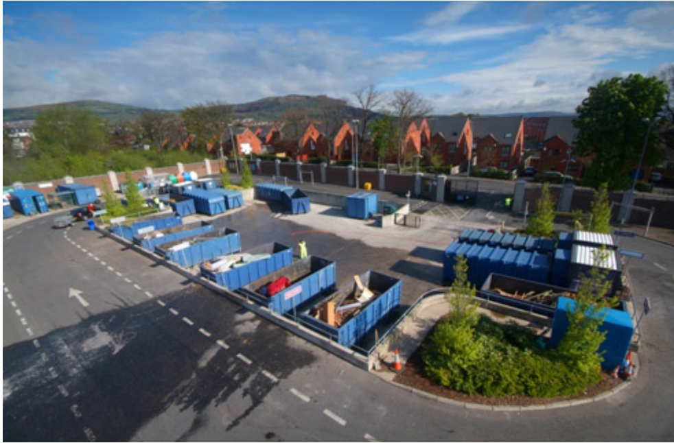
Слика 6.8. Изглед једног рециклажног дворишта
